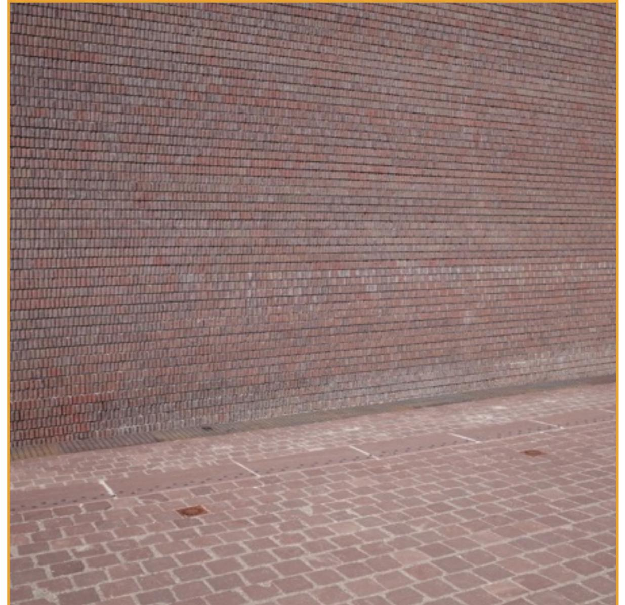
Les murs extérieurs sont réalisés avec des briques coupées en deux.
